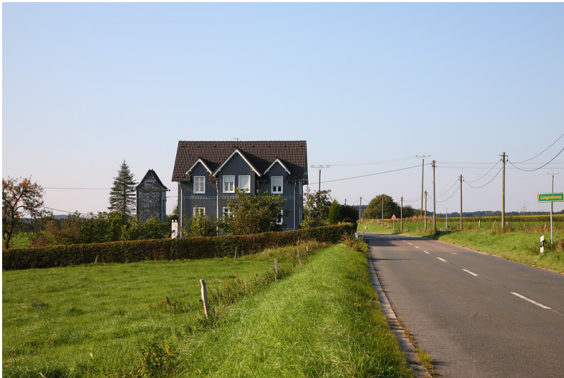
Einzelansiedlung Langenkamp mit Transformatorenhäuschen (2008) Fotograf/Urheber: Ulla Anne Giesen
