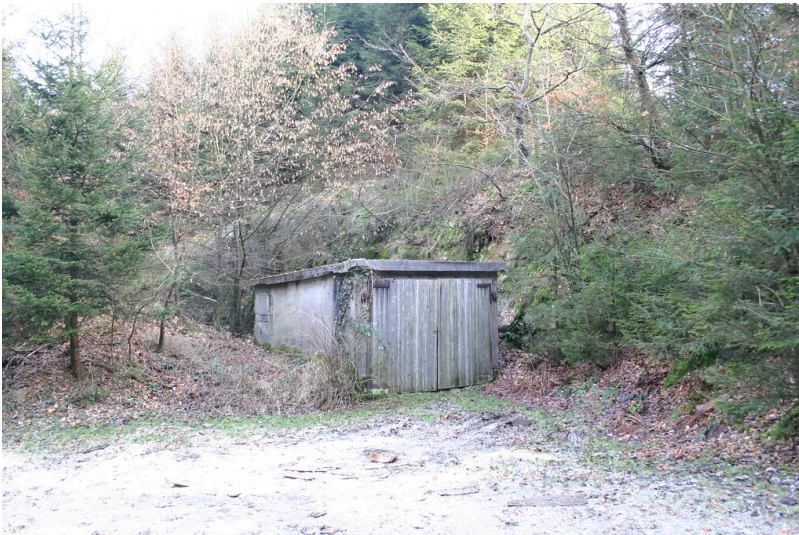
Steinbruch bei Hönde (2008) Fotograf/Urheber: Nicole Schmitz
