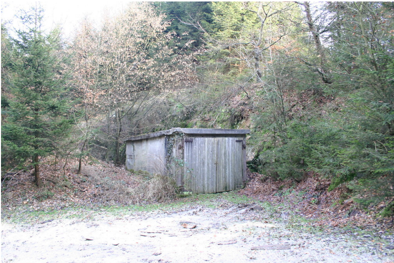
Steinbruch bei Hönde (2008) Fotograf/Urheber: Nicole Schmitz
