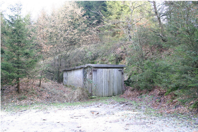
Steinbruch bei Hönde (2008) Fotograf/Urheber: Nicole Schmitz
