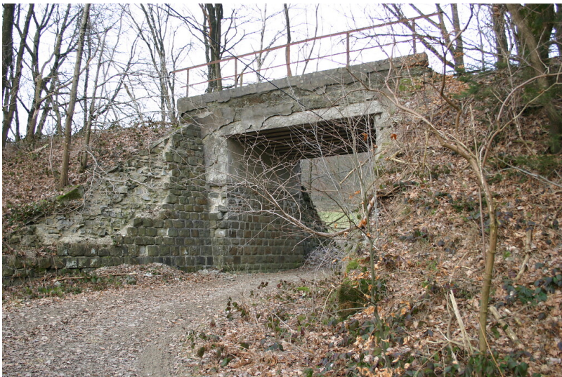
Eisenbahnunterführung der Bahnlinie Radevormwald-Brügge bei Felsenbeck (2008) Fotograf/Urheber: Nicole Schmitz
