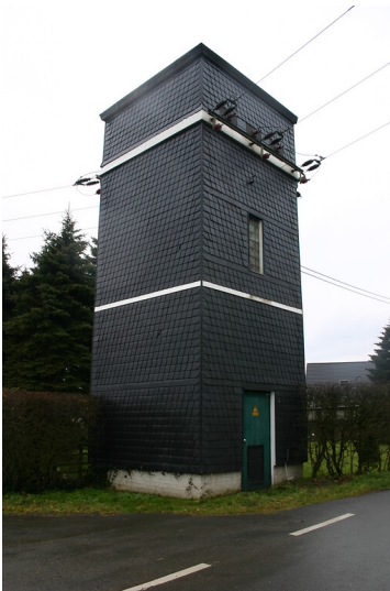
Verschieftes Transformatorenhaus in Wönkhausen (2008) Fotograf/Urheber: Nicole Fischer
