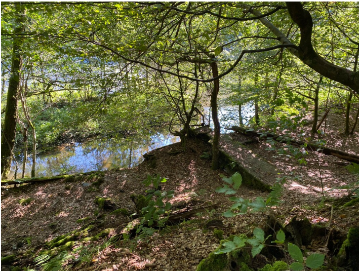
Reste des Stauwehres und Obergrabens des Elektrizitätswerkes Oedeschlenke (2024) Fotograf/Urheber: Nicole Schmitz
