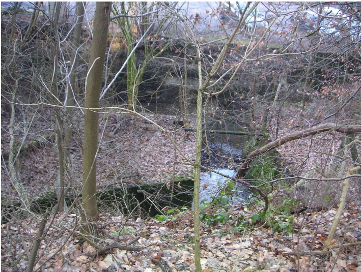
Die Wassergräben der ehemaligen Mühlen- und Hämmeranlagen in Krebsöge sind erhalten (2008) Fotograf/Urheber: Beate Lange
