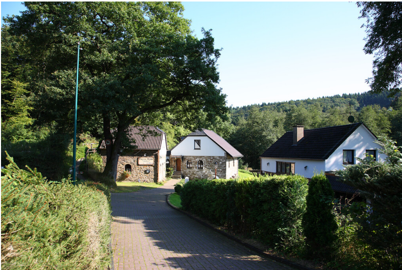
Blick von Westen auf die Wassermühlenanlage Oberste Mühle (2008) Fotograf/Urheber: Ulla Anne Giesen
