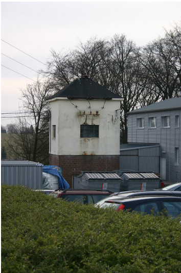
Transformatorenhaus in Feldmannshaus (2008) Fotograf/Urheber: Nicole Schmitz
