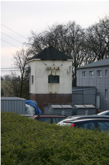
Transformatorenhaus in Feldmannshaus (2008) Fotograf/Urheber: Nicole Schmitz
