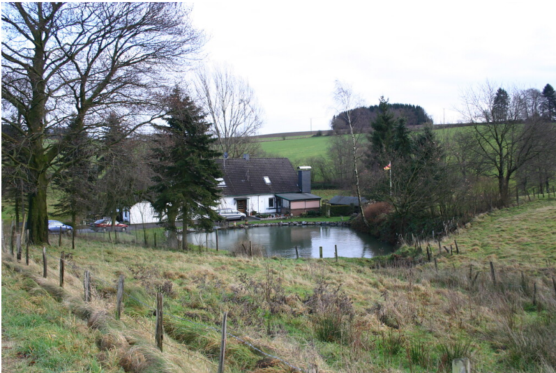
Blick auf den Mühlenteich und das Gebäude der Lambecker Mühle (2008) Fotograf/Urheber: Nicole Schmitz
