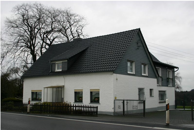
Wohnhaus der Einzelsiedlung Möllersbaum an der B 483 (2008) Fotograf/Urheber: Nicole Schmitz
