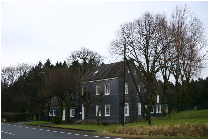
Mit Schiefer verkleidetes und von Hausbäumen umgebenes Wohnhaus in Landwehr (2008) Fotograf/Urheber: Nicole Schmitz
