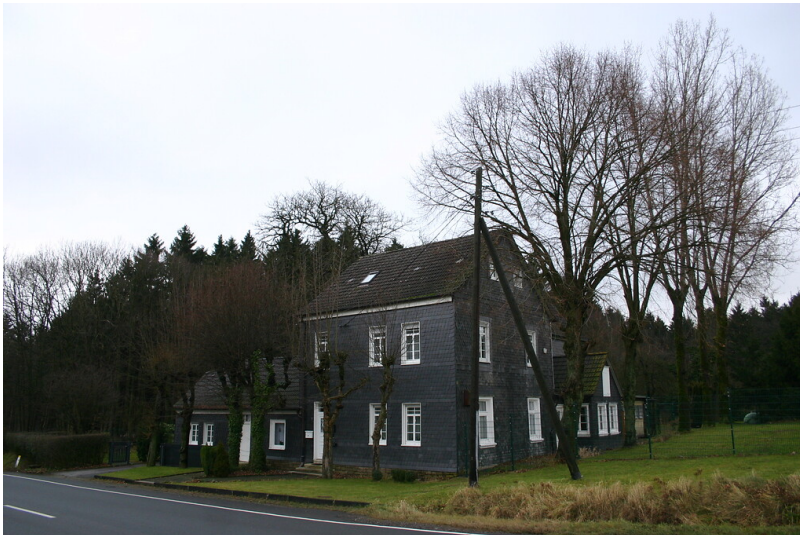
Mit Schiefer verkleidetes und von Hausbäumen umgebenes Wohnhaus in Landwehr (2008) Fotograf/Urheber: Nicole Schmitz
