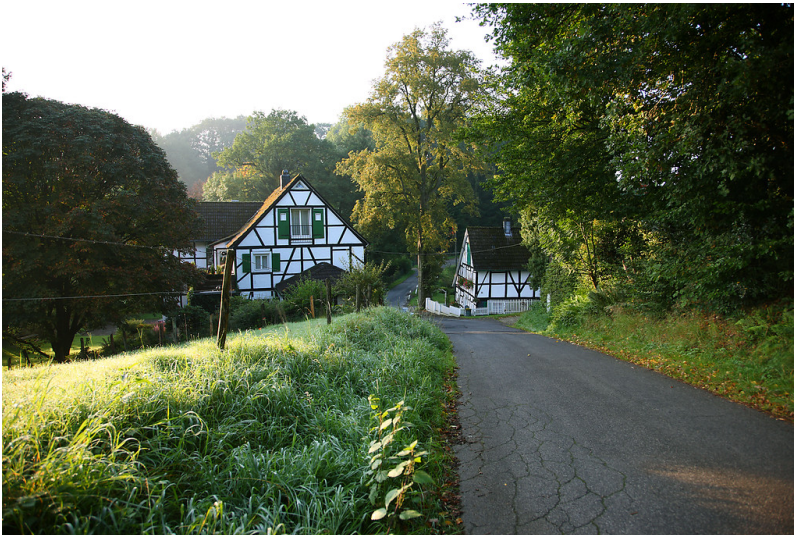
Fachwerkgebäude in Kaffekanne (2008) Fotograf/Urheber: Giesen, Ulla Anne
