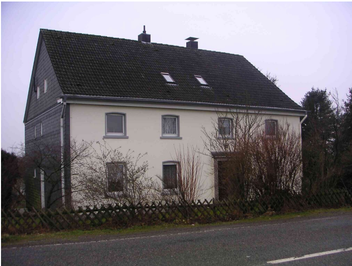
Der Standort dieses traufseitig verputzten und an den Giebeln verschieferten Gebäudes in Grünenbaum ist bereits auf der Bürgermeistereikarte von 1828 eingetragen (2008) Fotograf/Urheber: Beate Lange
