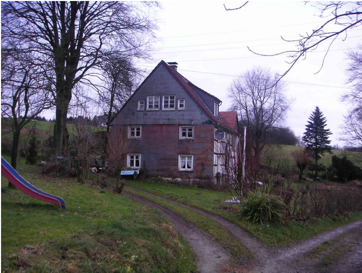
Fachwerkgebäude an historischem, bereits 1828 kartographisch verzeichnetem Standort in Oberfeckinghausen (2007) Fotograf/Urheber: Beate Lange
