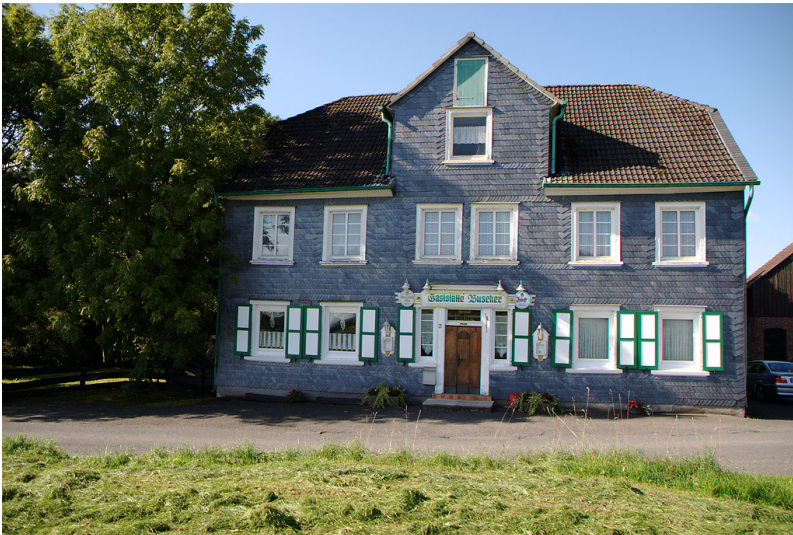
Ehemalige Gaststätte Buscher in Neuenholte (2008) Fotograf/Urheber: Attermeyer, Adolf
