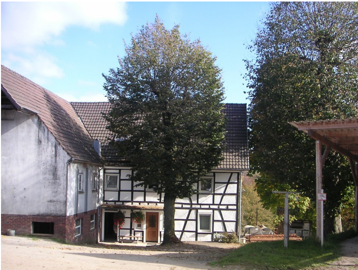
Fachwerkhof mit Hofbaum in Schückhausen (2007) Fotograf/Urheber: Lange, Beate
