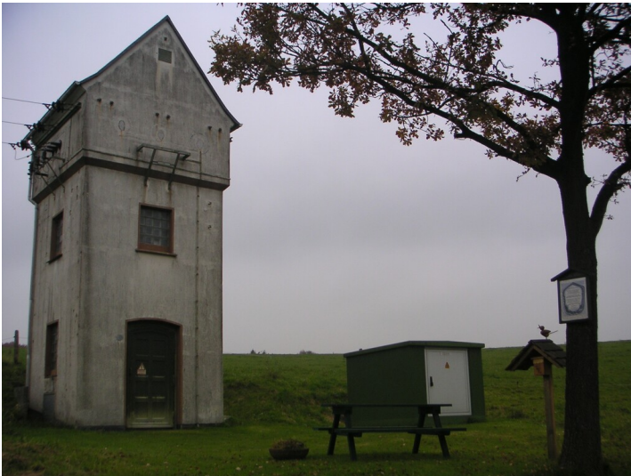
Transformatorenhäuschen in Kormannshausen (2007) Fotograf/Urheber: Beate Lange
