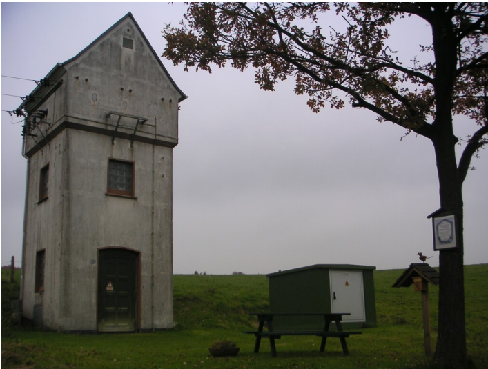
Transformatorenhäuschen in Kormannshausen (2007) Fotograf/Urheber: Beate Lange
