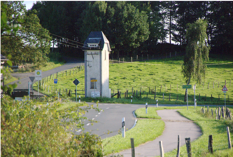
Transformatorenhäuschen mit Weideland und Baumgruppen in Straßburg (2008) Fotograf/Urheber: Attermeyer, Adolf
