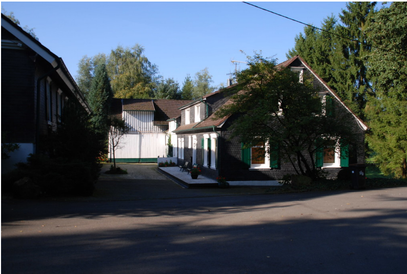
Historisches Wohngebäude in Dörpersteeg (2008) Fotograf/Urheber: Attermeyer, Adolf
