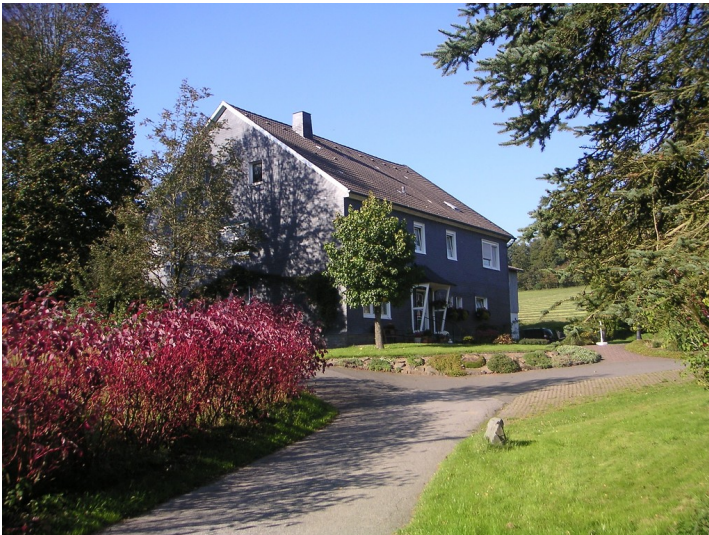
Historische Hofstelle in Frohnhausen (2007) Fotograf/Urheber: Lange, Beate
