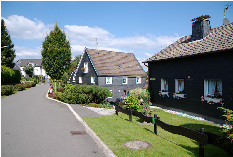
Verschieferte, historische Wohngebäude an der Straße in Oberwinterhagen (2008) Fotograf/Urheber: Attermeyer, Adolf
